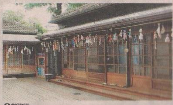
實建築 故事館本身為歷史建築，如木門、屋頂黑瓦及後院走道等，都可見日式建築的特色。
